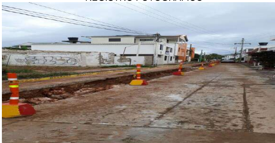
Figura 17. Inicio de obra en sector de cabañas altamar
